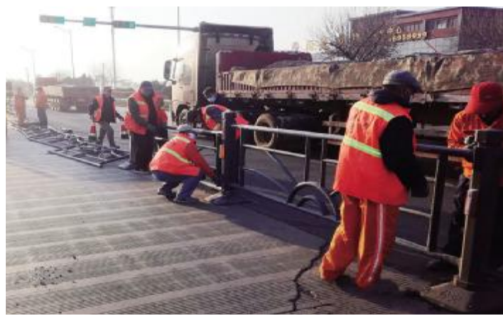
日前,华茂盛达市政公司顺利安装开发区大港路隔离护栏 100 余米,有效解决该路段机动车随意调头、非机动车、行人横穿马路等问题,为过往车辆、附近小区居民的出行提供一层安全保障。(秦月)
